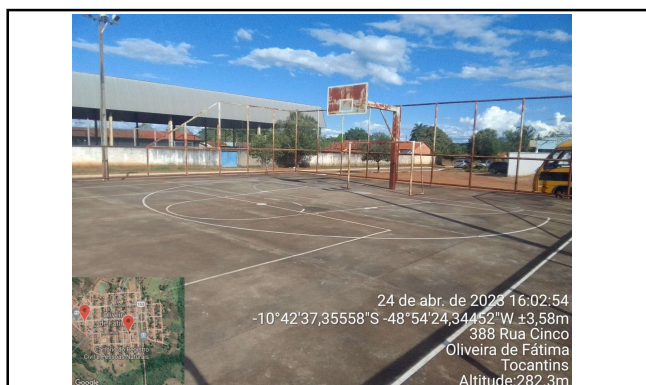
FOTO 02 - PISO DA QUADRA DE ESPORTE
