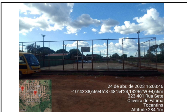
FOTO 05 - ALAMBRADO DA QUADRA DE ESPORTE
